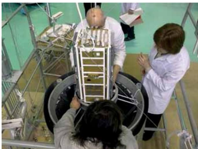
**Рис. 21.** СКБ КП ИКИ РАН. Окончательная упаковка МС «Чибис-М» в транспортно-пусковой контейнер
