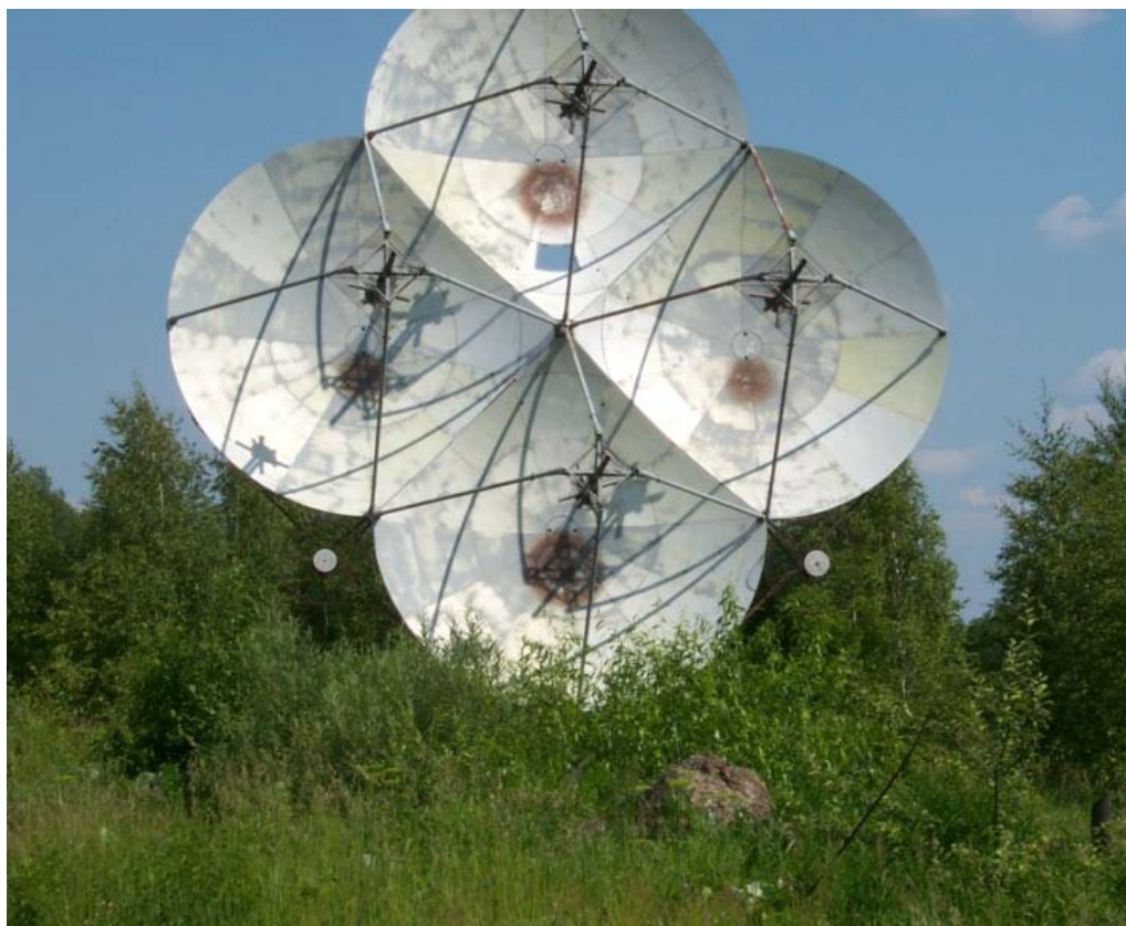
Рис.4.16. Антенна приемно-передающего пункта в г.Таруса.
